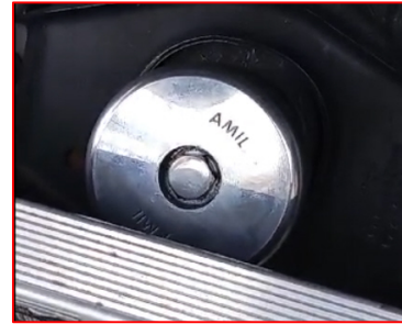
Reparo do bocal com a tampa antivazamento
